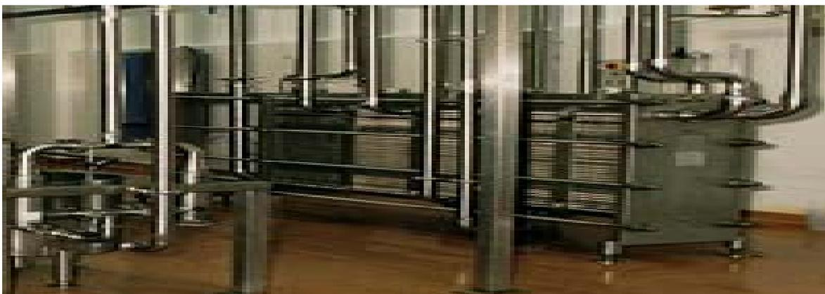
***Un pequeño intercambiador de calor a placas, utilizado en un pequeño sistema de pasteurización de lácteos***
