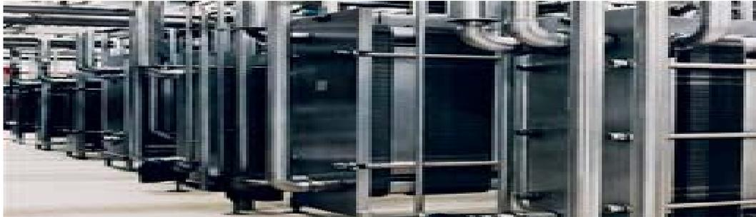
***Intercambiadores de calor para pasteurización de GEA Liquid Processing - utilizando un intercambiador de calor GEA Ecoflex a placas (PHE).***
