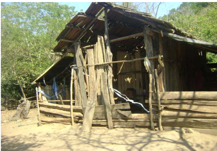
Estructuras de las viviendas visitadas
