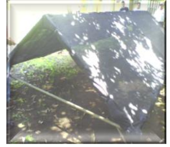
Ilustración 10: Techo con malla saran
