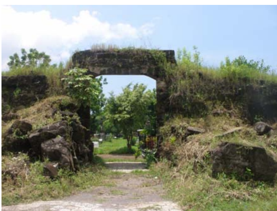
Foto 5: El estado actual de la muralla 1
