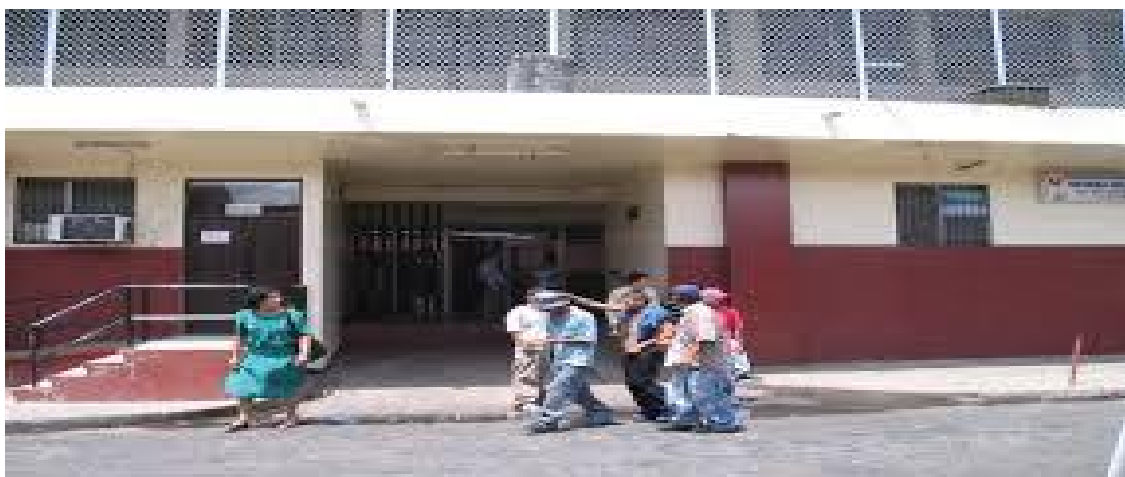
Ilustración N°03. Costado sur del Hospital, León, 2004
