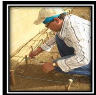
Colocación de los mecates
