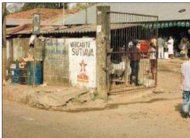
Ilustración N° 23. Entrada principal del Mercado Félix Pedro Carrillo, antes de la remodelación. 2000.
