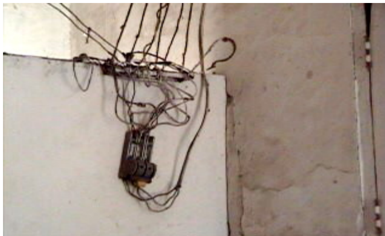
Conexión Eléctrica – Clínica Privada, Chichigalpa.
