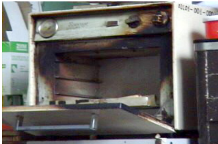
Autoclave Deteriorado – Centro de Salud, Chichigalpa
