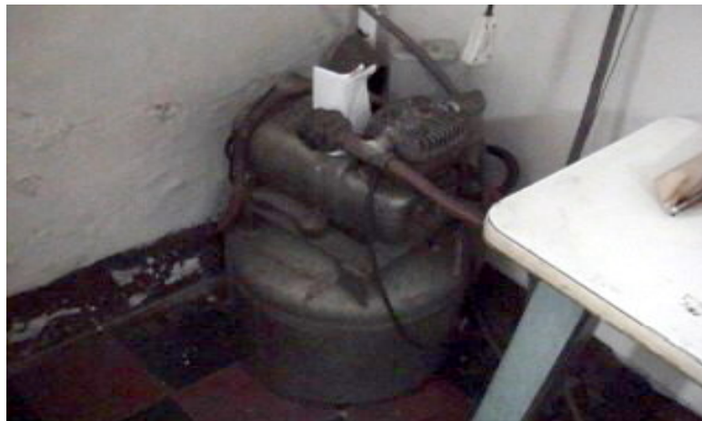
Compresor en el interior de la clínica – Hospital, Chinandega.
