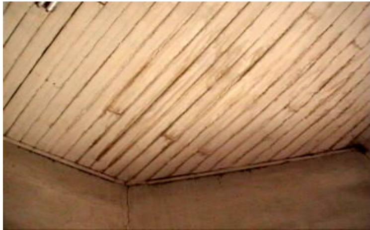
Cielo raso en mal estado.
