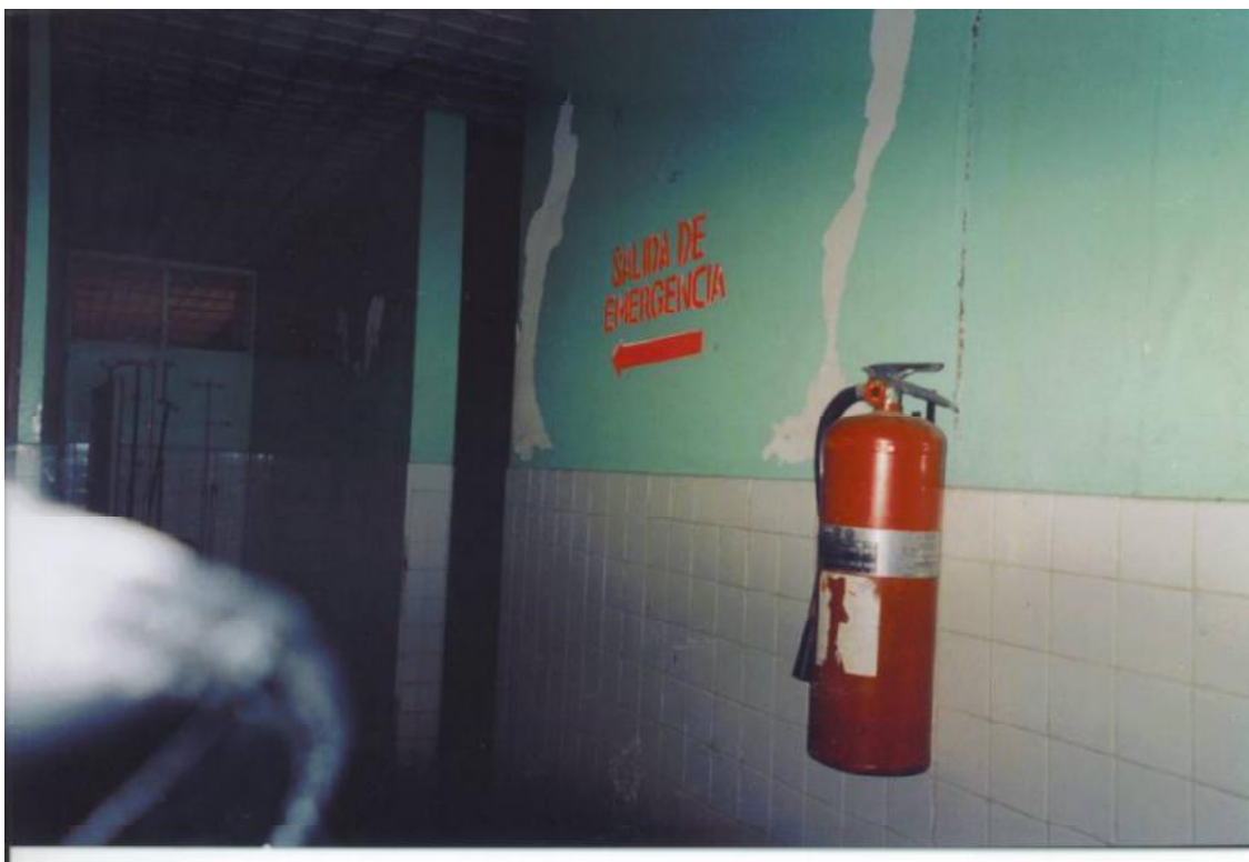
FRACTURA DE PARED
