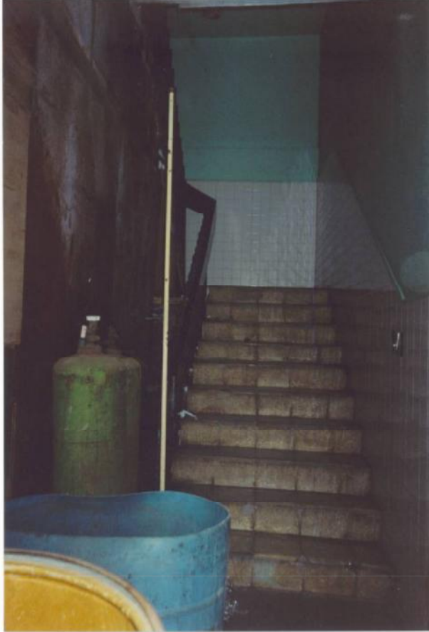
ESCALERA SALIDA A EMERGENCIA SOTANO OCT-2006
