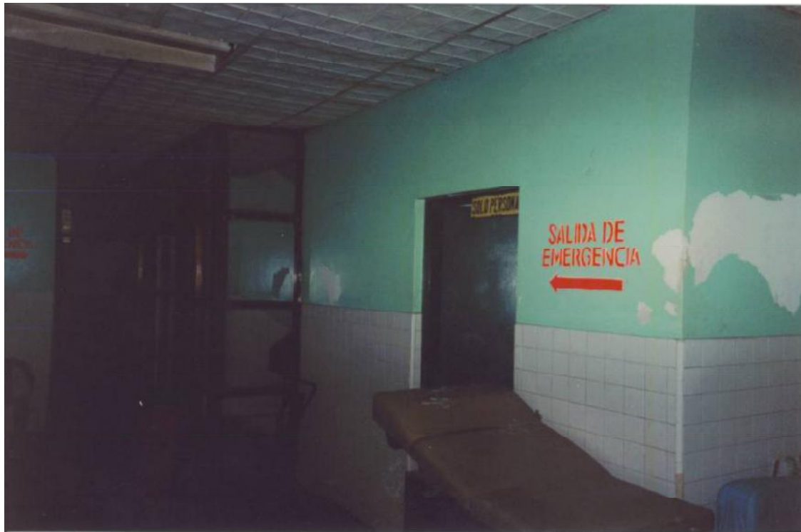
SEÑALIZACION DE SALIDA DE EMERGENCIA
