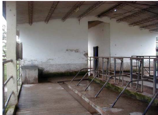
Sala de ordeño con sus bretes, comederos, pila para almacenar agua clorada, cerca perimetral y drenajes.
