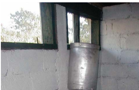
Paredes y área de ventilación natural del cuarto de utensilios.
