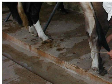
El canal de drenaje interno ubicado inmediatamente atrás de la posición que ocupan las vacas al ordeñarse.
