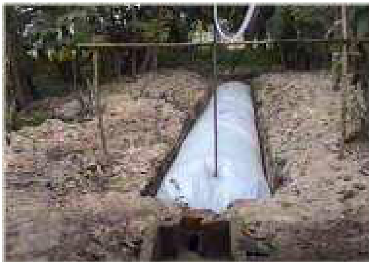
Biodigestor de estructura flexible
