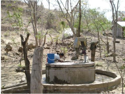
Fig. 11. Pozo con bomba de mecate rota. La extracción tiene que hacerse manualmente con riesgo de introducir contaminantes en el pozo.
