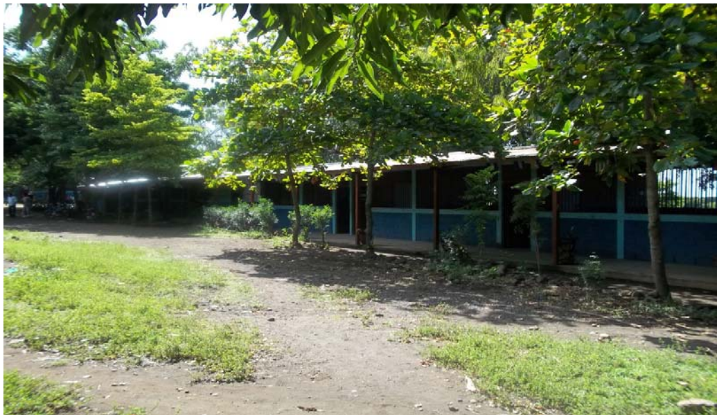
Vista sur del centro.
