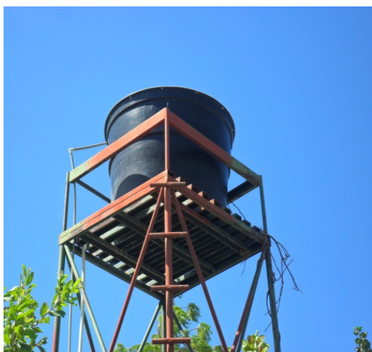
Figura7. Abastecimiento de agua.
