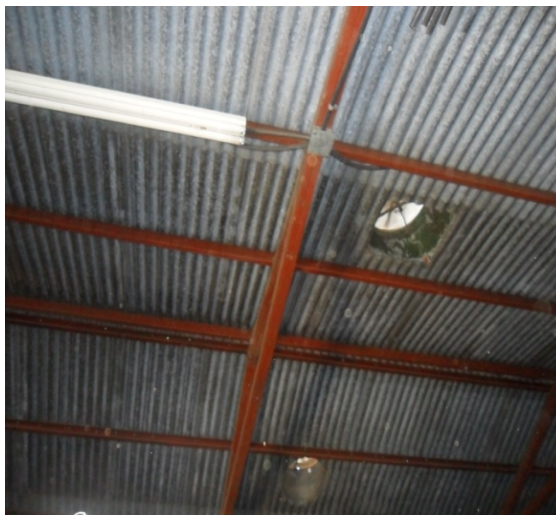
Figura 7. Techo de bodega
