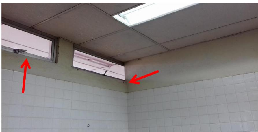
**Figura 9.** Se señalan las ventanas superiores que están a lo largo de la pared que da hacia el pasillo de ingreso, las cuales no son adecuadas y se encuentran con mucha suciedad, además de las ya mencionadas esquinas que se encuentran similarmente en todo el laboratorio.
