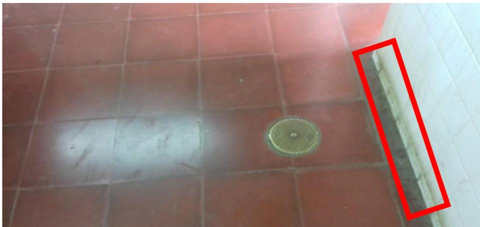
**Figura 28.** Se enmarca la unión incorrecta y se observa el tipo de cerámica utilizado el cual no es el correcto para un laboratorio académico.
