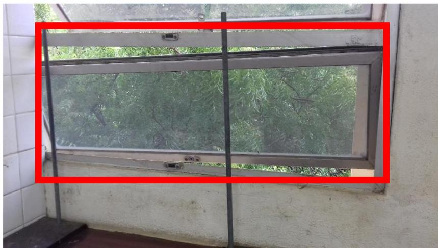
**Figura 11.** Acercamiento a las ventanas de la figura anterior, con recuadro, para evidenciar el mal estado de las ventanas y la mala higiene de estas.
