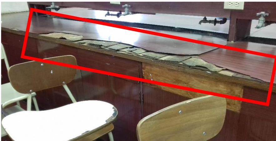
**Figura 22.** Se enmarca la orilla de la mesa de trabajo con evidente deterioro.
