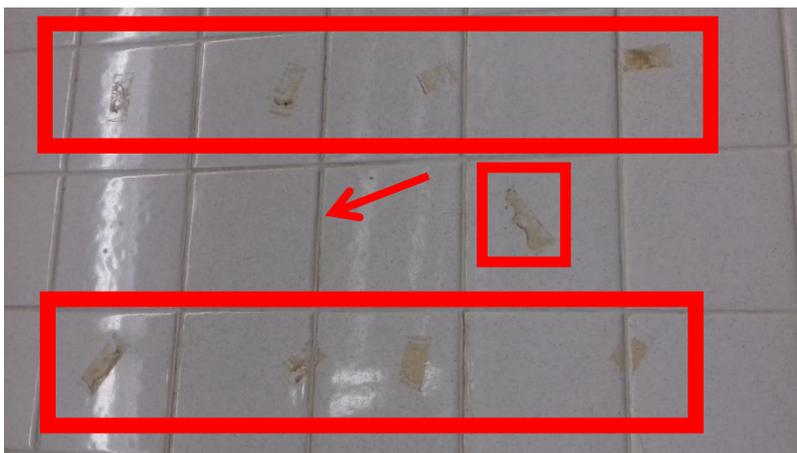
**Figura 14.** Enmarcamiento de restos de cinta adhesiva en la pared, evidenciando la mala higiene, además demostrando que la cerámica utilizada en las paredes no es apta para un laboratorio.
