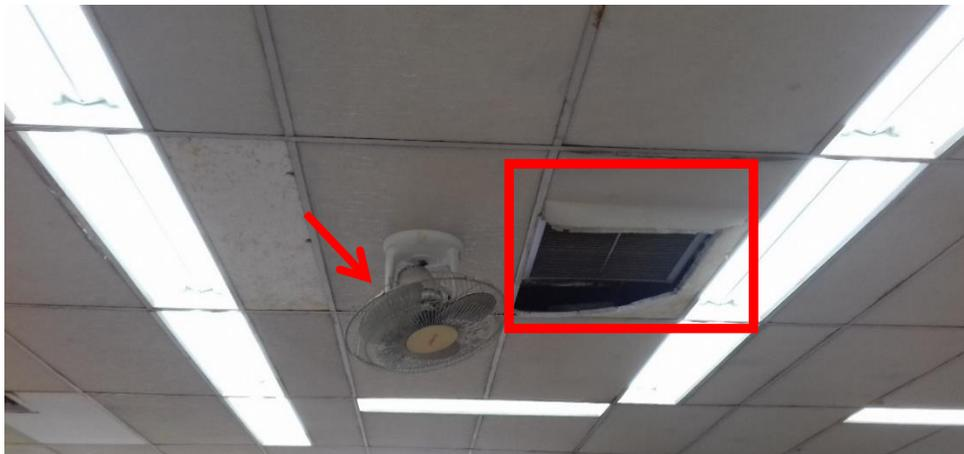
**Figura 7.** Se señala uno de los abanicos en mal estado y el sistema antiguo de ventilación que poseía el ambiente (recuadro), el cual está deteriorado.
