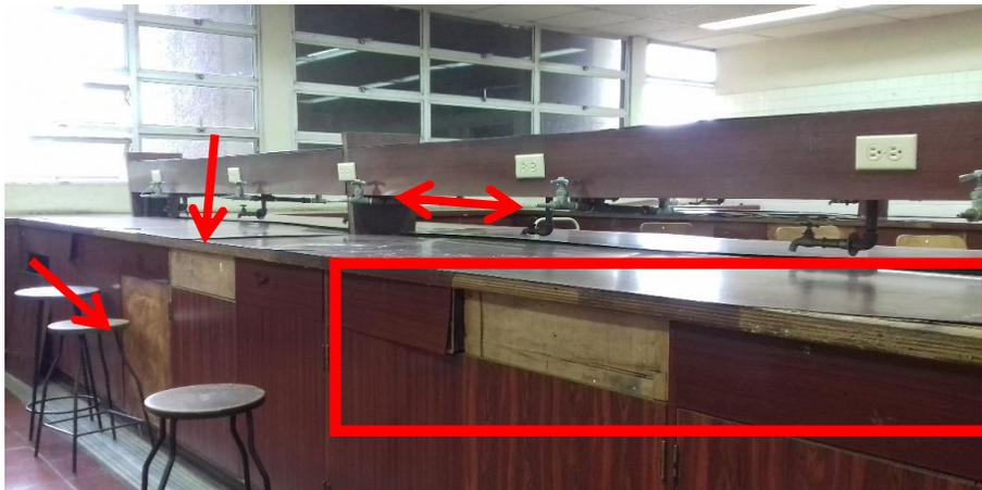
**Figura 20.** Aquí se señalan con flechas las partes deterioradas y los grifos, que no están en funcionamiento. Y se enmarca con un rectángulo la orilla de la mesa en mal estado.
