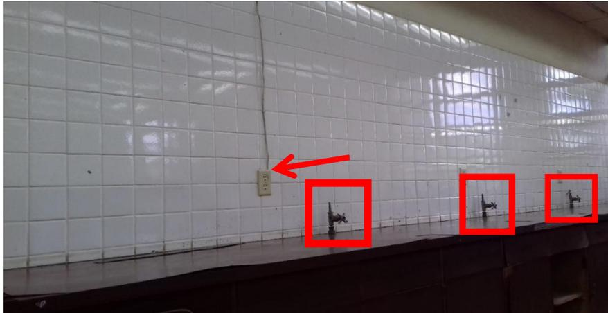
**Figura 12.** Señalamiento con flechas, los enchufes que según las normas no deben ser así. Además enmarcados con recuadros están los grifos en mal estado y fuera de funcionamiento.
