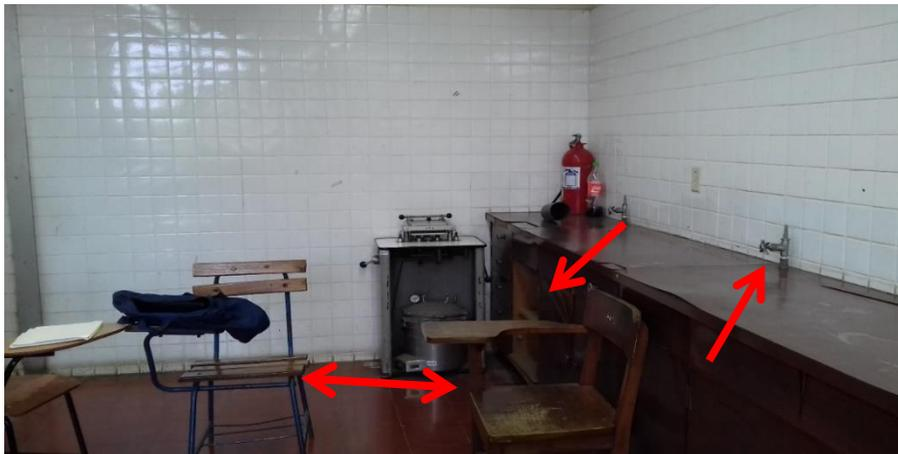
**Figura 18.** Se señala otra de las mesas en mal estado, sin puertas y despegado el material que reviste la mesa. Al igual están pupitres que no deben usarse en un laboratorio.
