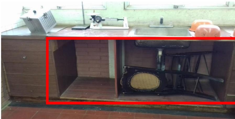
**Figura 36.** Mesa del lado Norte del área de equipos, la cual no posee puertas y se utiliza como bodega de sillas en mal estado, además está el lavamanos que no funciona.
