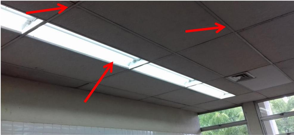
**Figura 6.** Fotografía tomada del cielo-falso del Laboratorio de Tecnología Farmacéutica con las indicaciones (flechas) de los elementos de incumplimiento de las BPM.
