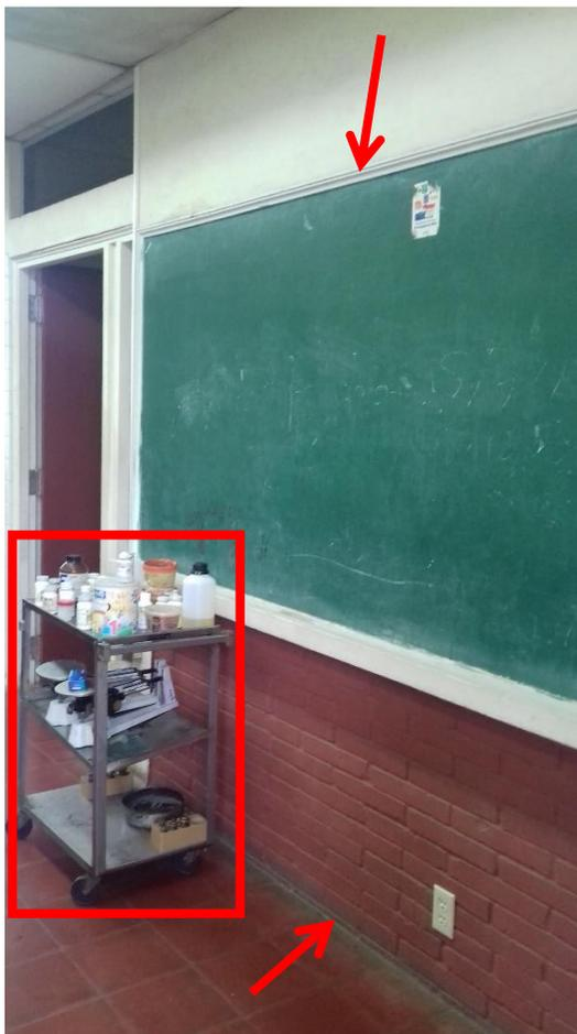
**Figura 16.** Señalado con una flecha está la pizarra de tiza, la cual no es apta para laboratorios, por ser propensa a generar suciedad, comprometiendo la calidad de los medicamentos elaborados.
