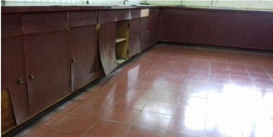
**Figura 19.** A simple vista se observa el deterioro de la mesa de trabajo, la cual hay que señalar que no deberían ser de ese material.
