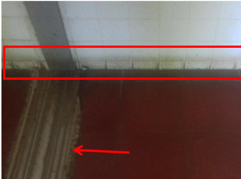
**Figura 27.** Acercamiento a la unión continua de aluminio del laboratorio y enmarcado con un recuadro la intersección de piso y pared con evidencia de mala higiene.
