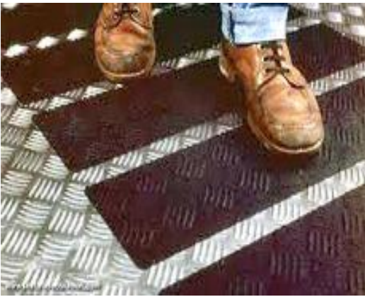
Figura 3.6.3: colocación de cinta antideslizante
