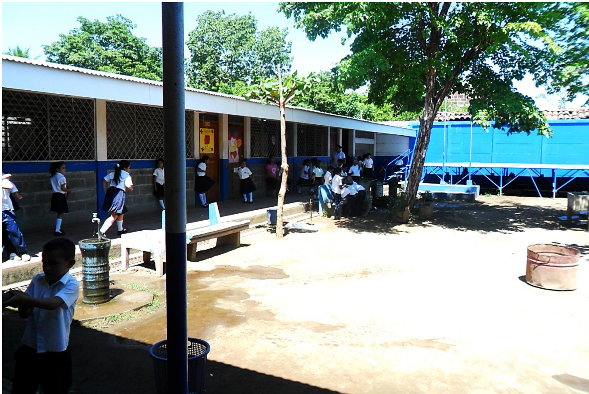
Instalaciones del Colegio Santiago Apóstol del municipio de Telica, departamento de León. Aquí los niños realizan sus actividades físicas.
