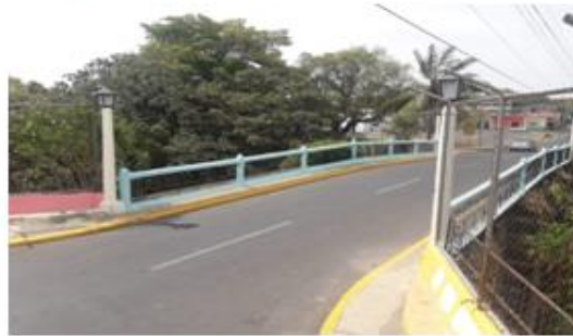
Puente de Guadalupe, principal vía conectando Norte y Sur de la ciudad de León. Fuente: Tomada por María Rueda Toval. Mayo. 2019
