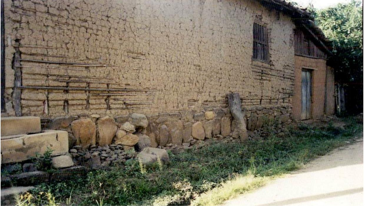
Foto N° 3. Vista Exterior de las Viviendas construidas de Pared de Adobe/ Taquezal.
