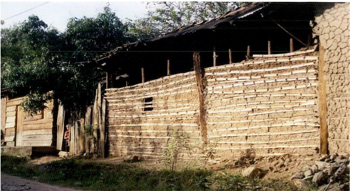
Foto N° 4. El Deterioro de las Paredes de las viviendas que favorece el Refugio a los Triatomas.
