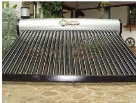
*Figura N° 20 Captador de Tubos de Vacío*
