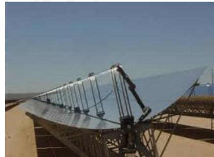
Figura N° 21 Concentrador solar cilíndrico parabólico
