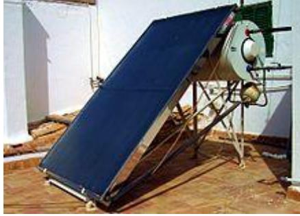
*Figura N° 19 Captador Solar Plano*
