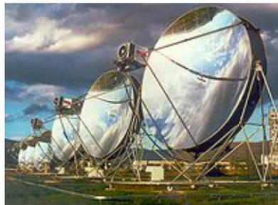
Estos colectores solares parabólicos concentran la radiación solar aumentando temperatura en el receptor.
