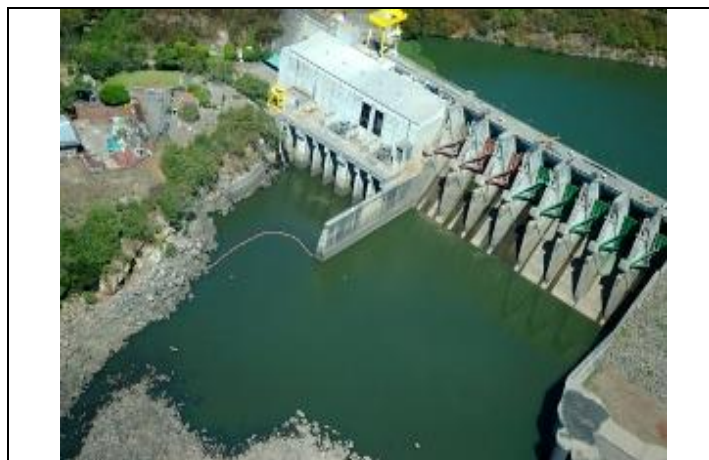
Figura 18. Central Hidroeléctrica 15 de Septiembre.
