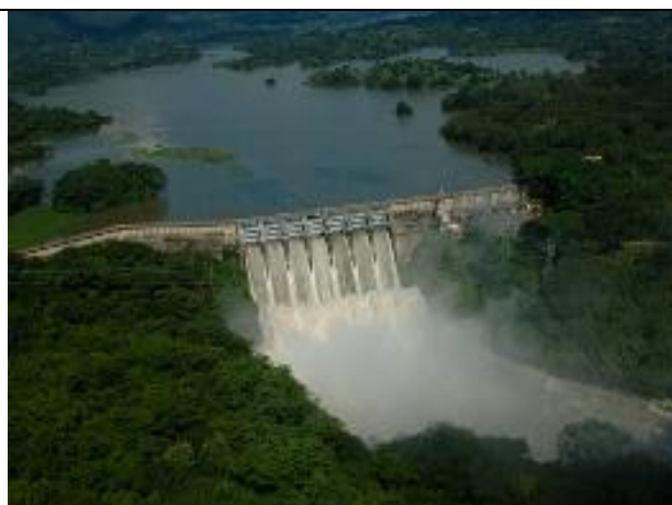
Figura 17. Central Hidroeléctrica 5 de Noviembre.
