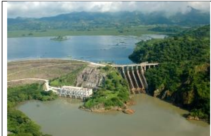
Figura 27. Central Hidroeléctrica Cerrón Grande.
