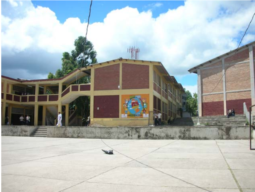
Edificio Instituto Superación San Francisco
